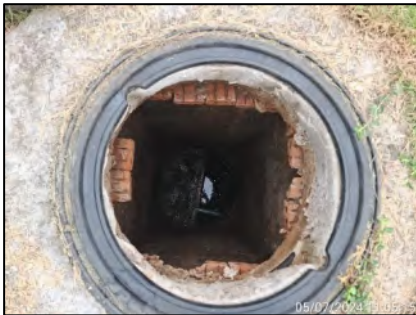
บ่อกักน้ำทิ้งหลังผ่านระบบบำบัดน้ำเสียของอาคารที่พักผู้โดยสาร ขาเข้า
