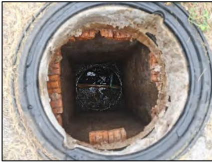
บ่อกักน้ำทิ้งก่อนผ่านระบบบำบัดน้ำเสียของอาคารที่พักผู้โดยสาร ขาเข้า
