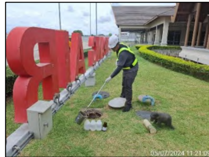
บ่อกักน้ำทิ้งก่อนผ่านระบบบำบัดน้ำเสียของอาคารที่พักผู้โดยสาร ขาออก
