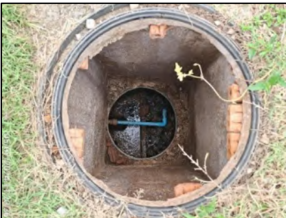
บ่อกักน้ำทิ้งก่อนผ่านระบบบำบัดน้ำเสียของอาคารที่พักผู้โดยสาร ขาออก
